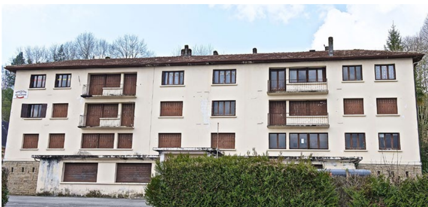
L'ancienne gendarmerie à Nay, qui va être démolie, sera le site du nouveau Centre culturel.
