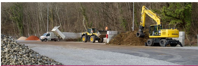
Le site permet la revalorisation des matériaux inertes et déchets professionnels.
