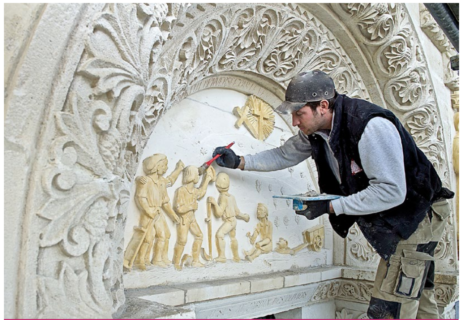
Les divers travaux de maçonnerie accompagnent une restauration, particulièrement minutieuse et un débroussaillage indispensable. Les travaux sont prévus jusqu'en 2021-2022.
