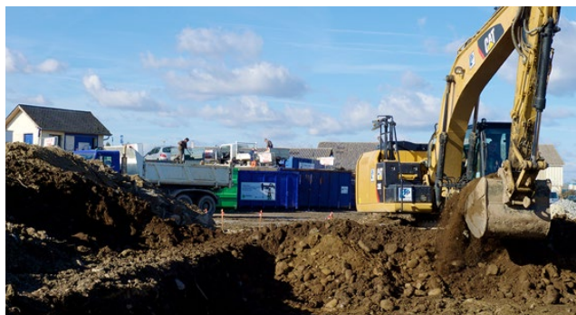
Travaux de terrassement préalables à l'extension des quais actuels que l'on distingue au fond.
