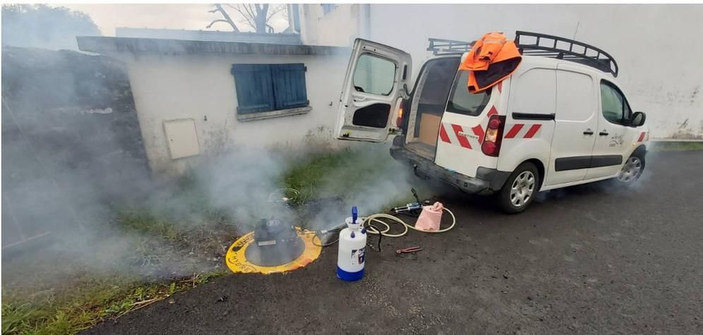
*Essais au fumigène depuis le réseau principal sur un branchement d'assainissement non conforme à Asson (Gouttières raccordées sur le réseau d'eaux usées).*
