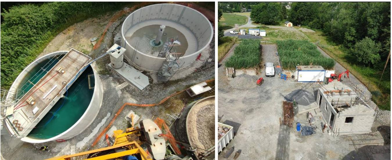
*Travaux d'extension de la station d'épuration de la commune d'Asson de 1000 à 2000 équivalents-habitants (à gauche : nouveaux bassin d'aération et clarificateur / à droite : local technique et vue sur les lits de roseaux pour les boues).*
