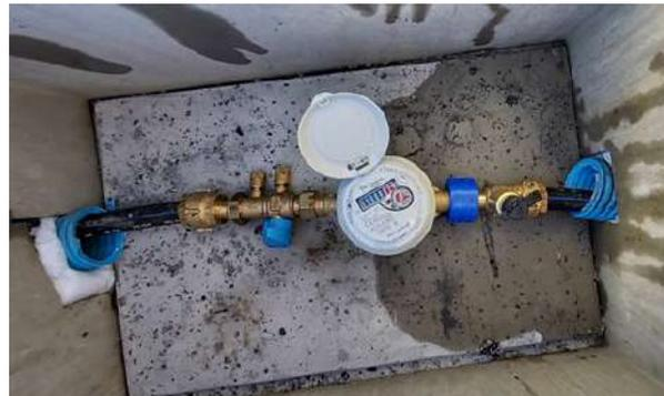
Mise à niveau d'un point de consommation (niche béton, compteur et ses accessoires)
