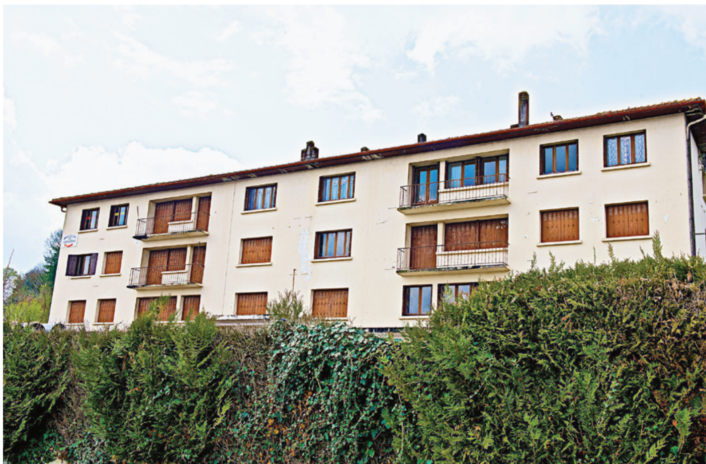
Actuellement utilisé par les associations, le bâtiment de l'ancienne gendarmerie serait démoli.
